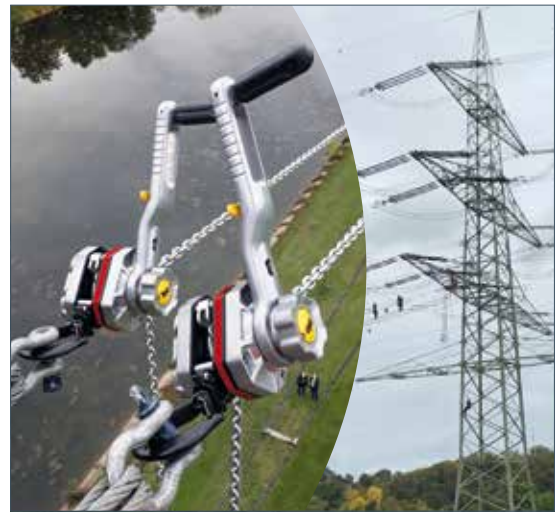
Einsatz des Yale ERGO 360® UT mit automatisch wirkender Fangvorrichtung im Freileitungsbau
