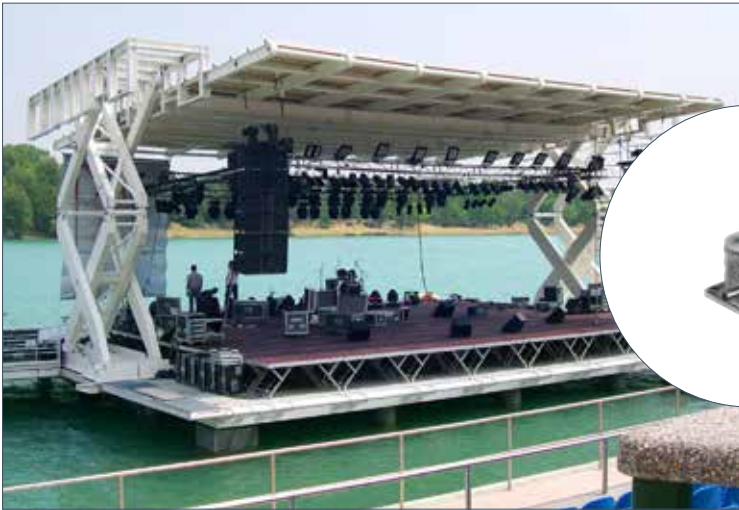
Optimierte Spindelhubelemente von Pfaff-silberblau heben und senken das Dach der Mailänder Seebühne zuverlässig und vor allem sicher.
