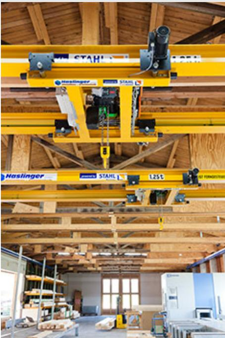
Die beiden Zweiträger-Hängekrane dienen in der Zimmerei zum flurfreien Transport von Holzbalken und fertigen Wand-Elementen.
