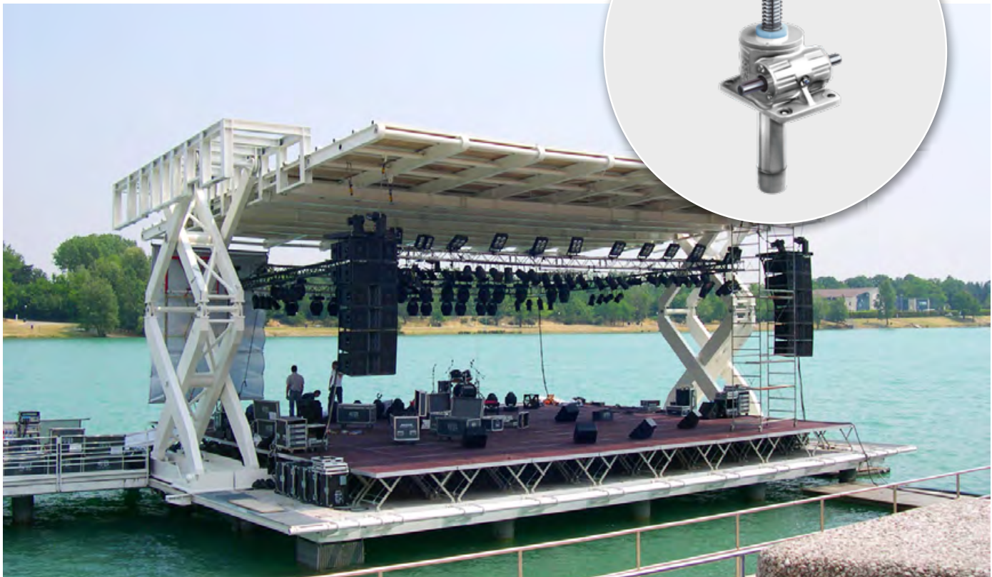
Optimierte Spindelhubelemente von Pfaff-silberblau heben und senken das Dach der Mailänder Seebühne zuverlässig und vor allem sicher. Bildquelle: Pfaff-silberblau
